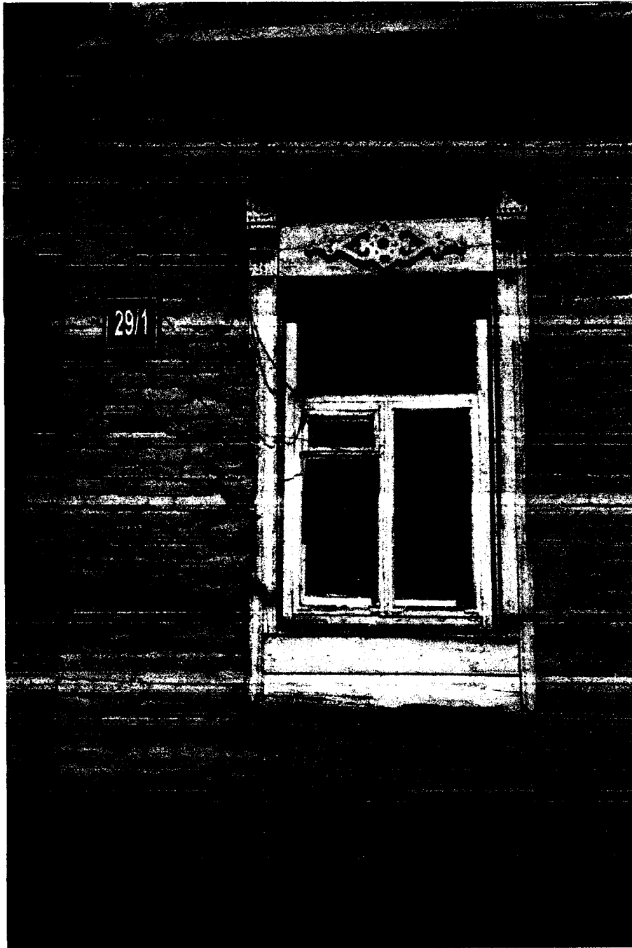
Фото 7. Фрагмент юго-западного фасада. Прямоугольное окно первого этажа юго-западного фасада здания, оформленное наличником; прямой сандрик наличника окон первого этажа юго-западного лицевого фасада здания, опирающийся на резные консоли и имеющие в тимпане растительный орнамент накладной пропиленной резьбы. Дата фотографии 3 августа 2018 года.
